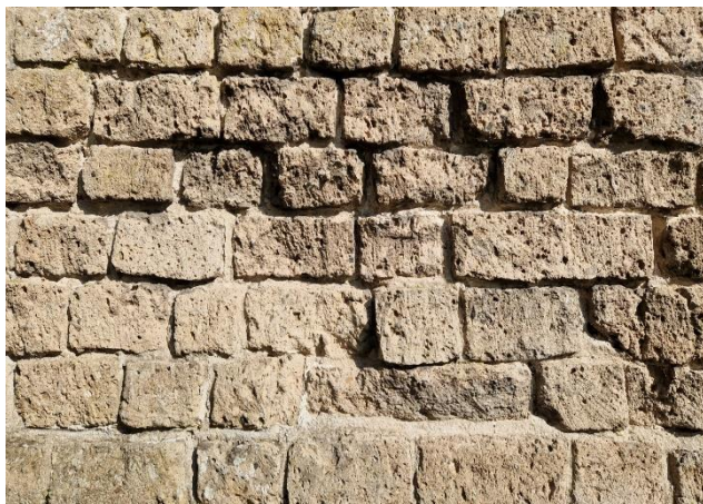
Foto 1. Detail muurgedeelte van tufsteen. Het is goed te zien dat dit behoorlijk poreus is.
